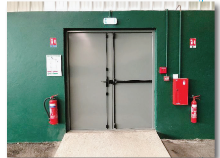
Pose de matériel défense incendie au Hall des sports.
